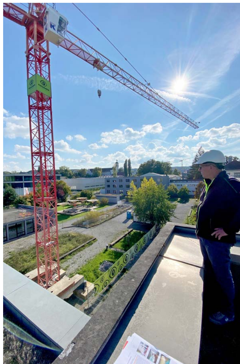
Der Bereich, in dem sich der Kran bewegen kann, muss gesperrt sein.
