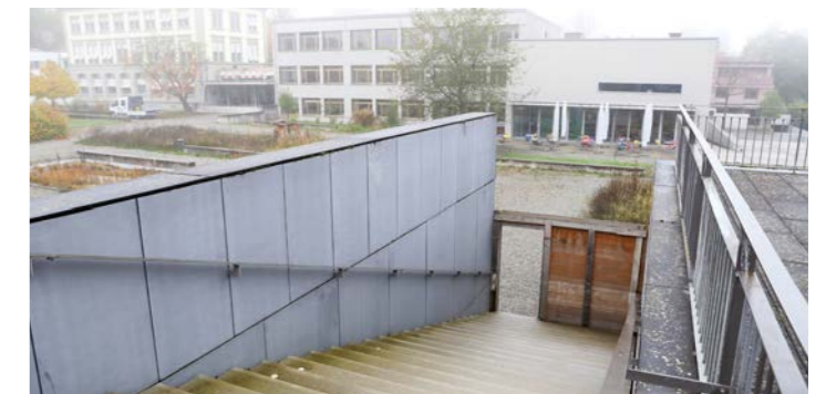
Die mobile Absperrung für die C-Treppe soll auch kommen.
